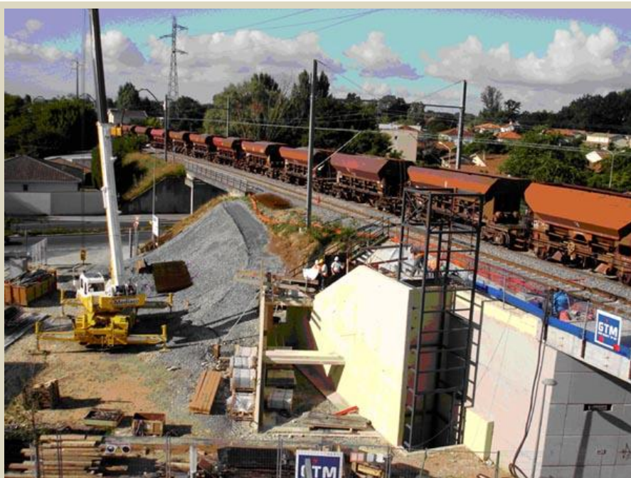
Un train "Meccoli" passant sur le chantier GTM en juillet 2010.
